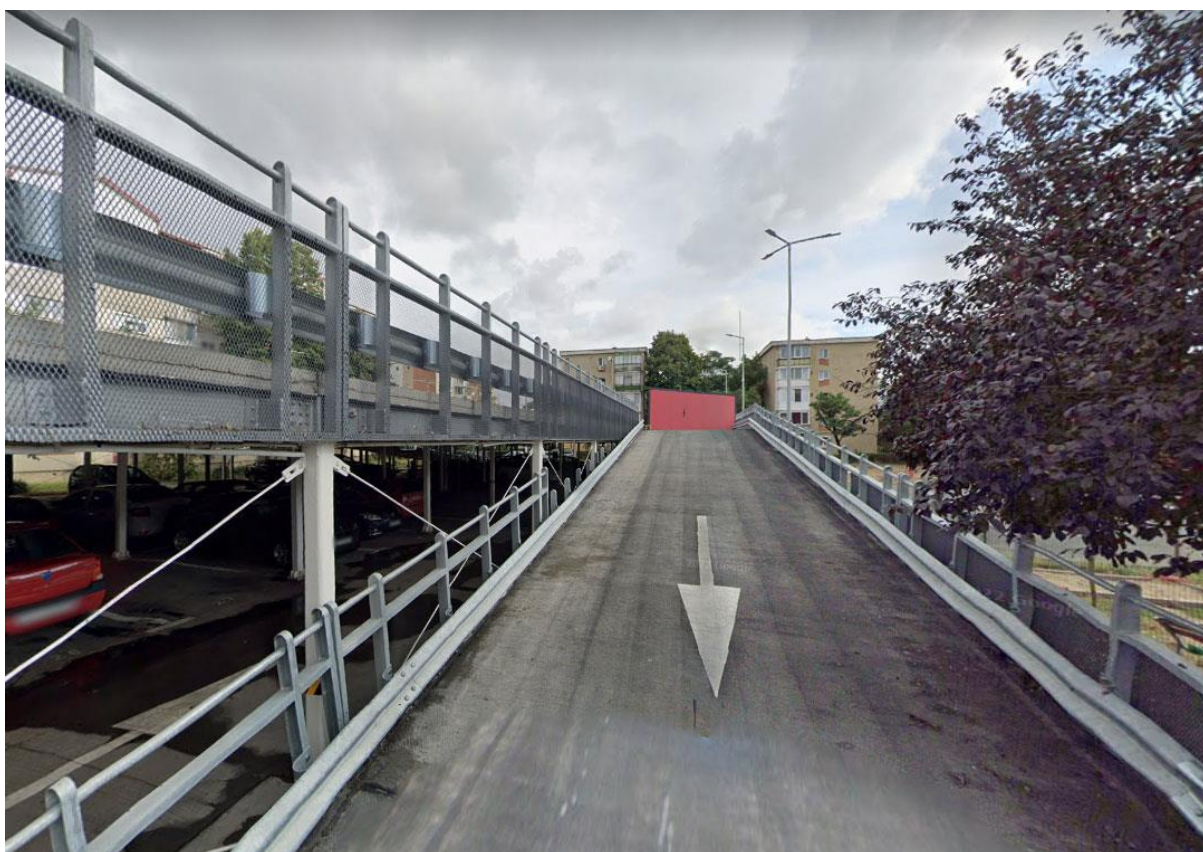
Figura 14 - Rampă acces/coborâre - Fast park 1 - Str. Tunarilor
